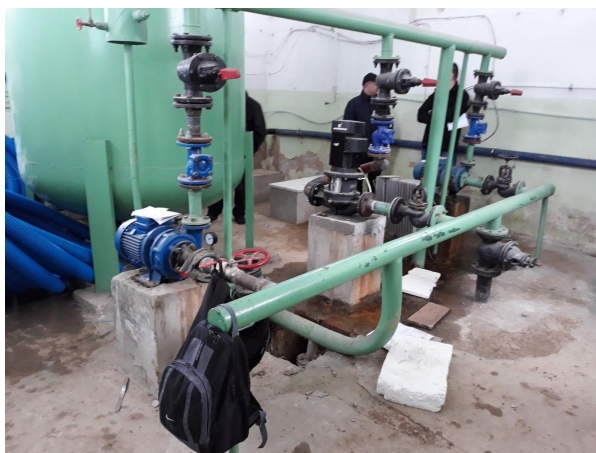
Układ pompowy wraz z armaturą
