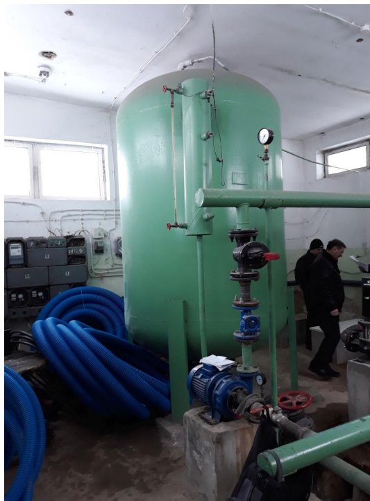
Zbiornik wody przed układem pompowym
