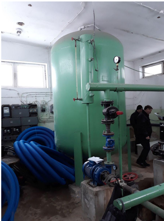
Zbiornik wody przed układem pompowym
