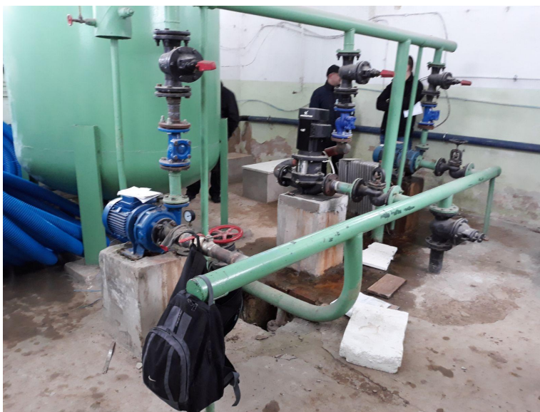
Układ pompowy wraz z armaturą
